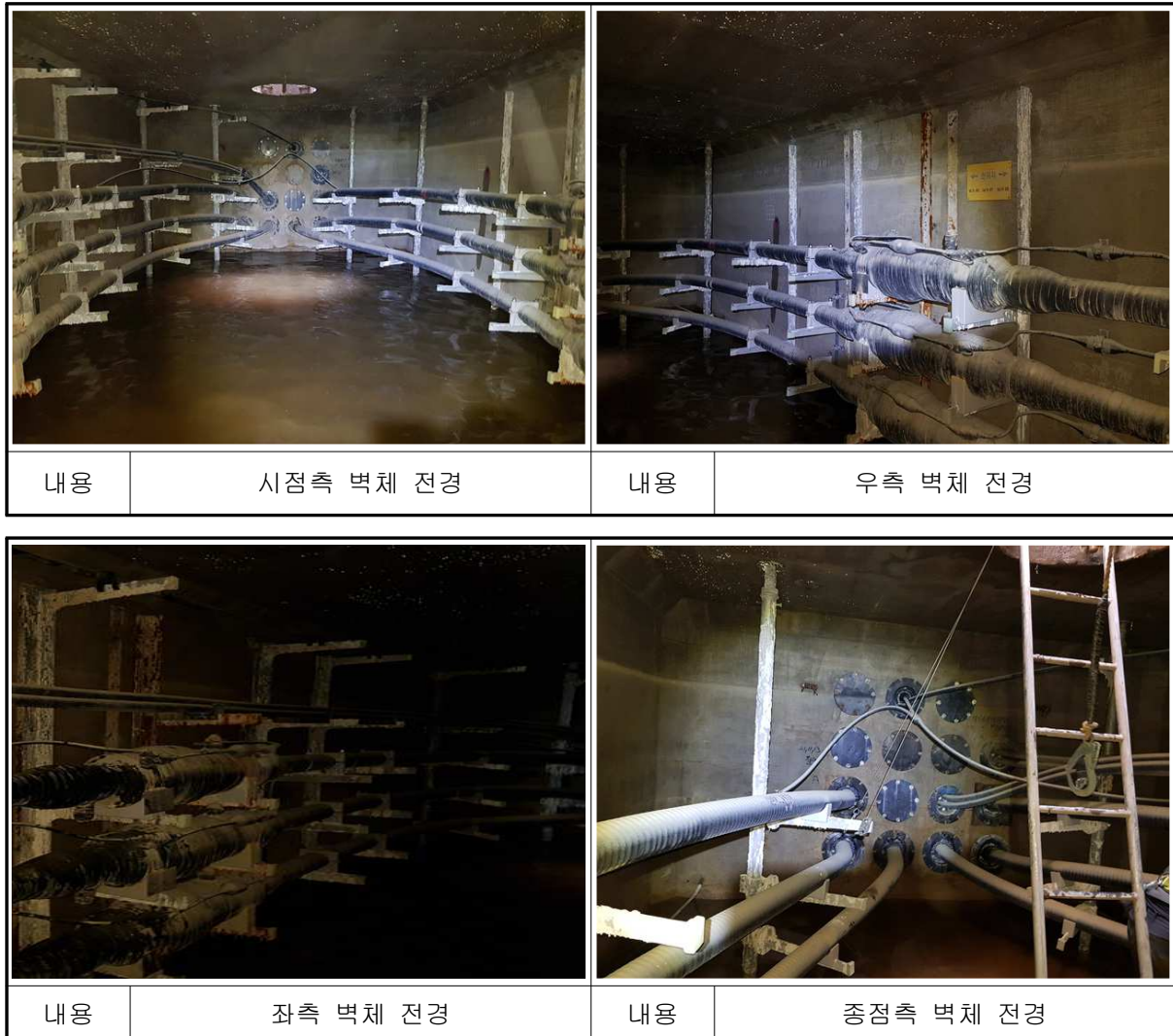
【사진 7.25】 문발~운정 #7 전경
