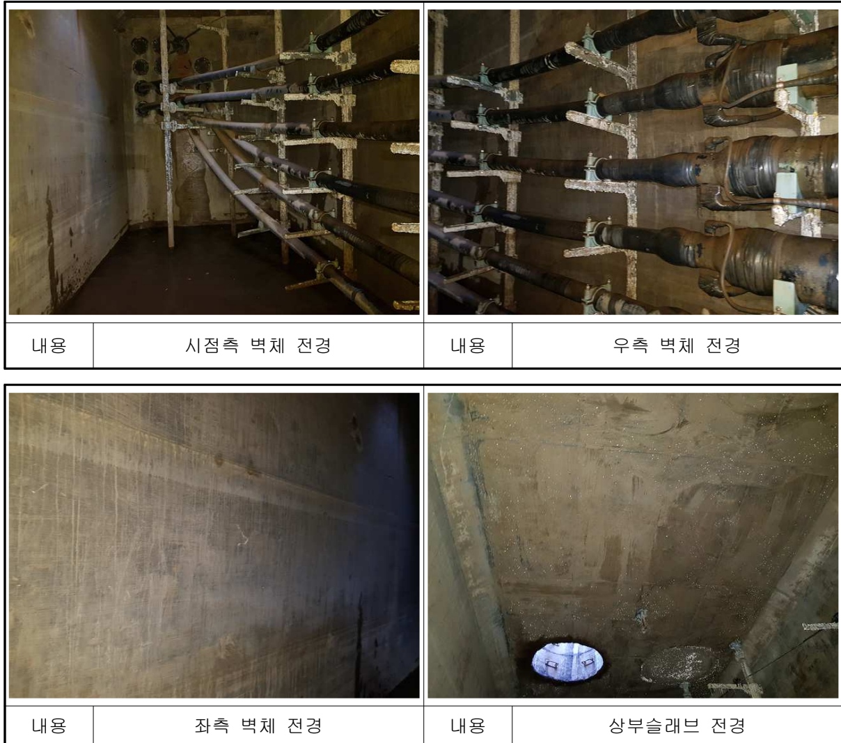
【사진 7.5】 문발~운정 #2 전경
