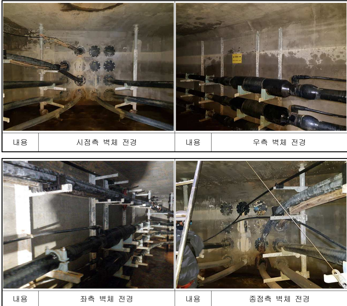
【사진 7.21】 문발~운정#6 전경
