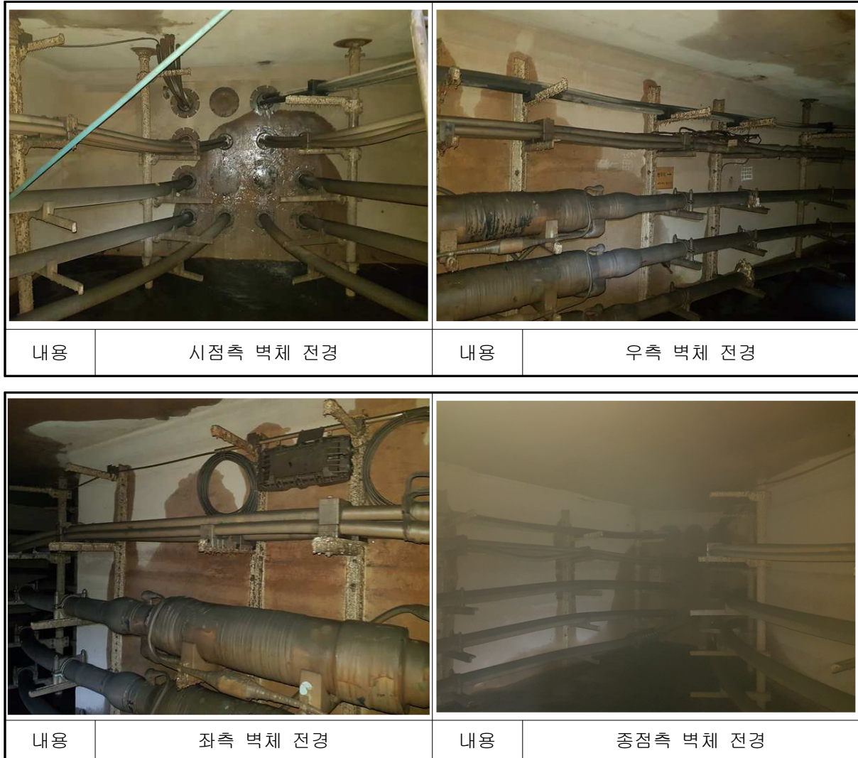
【사진 7.61】 운정~덕이#7 전경
