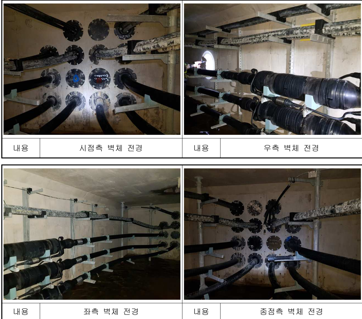
【사진 7.73】 운정~덕이#10 전경
