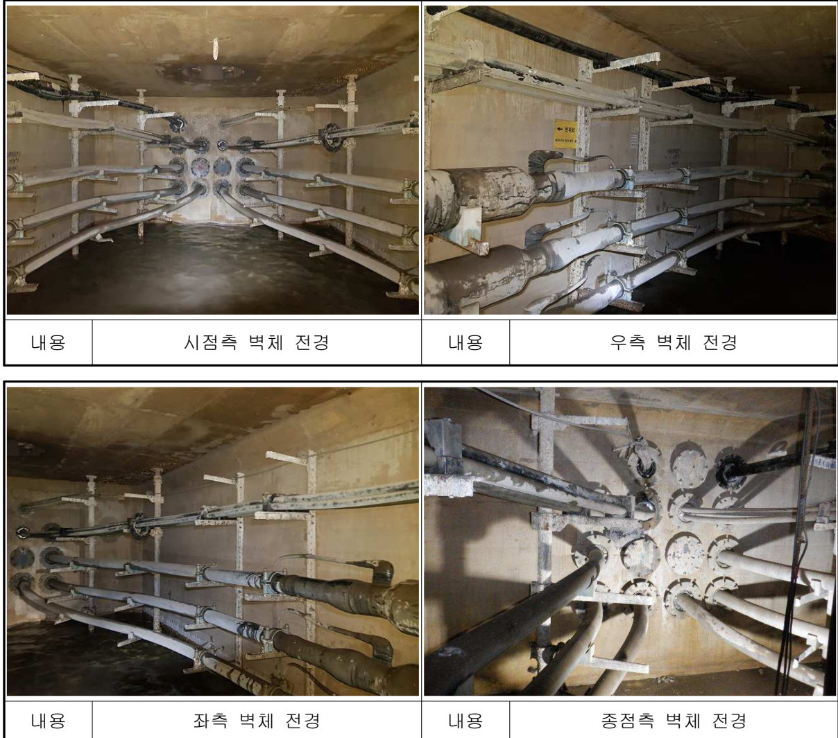
【사진 7.65】 운정~덕이#8 전경
