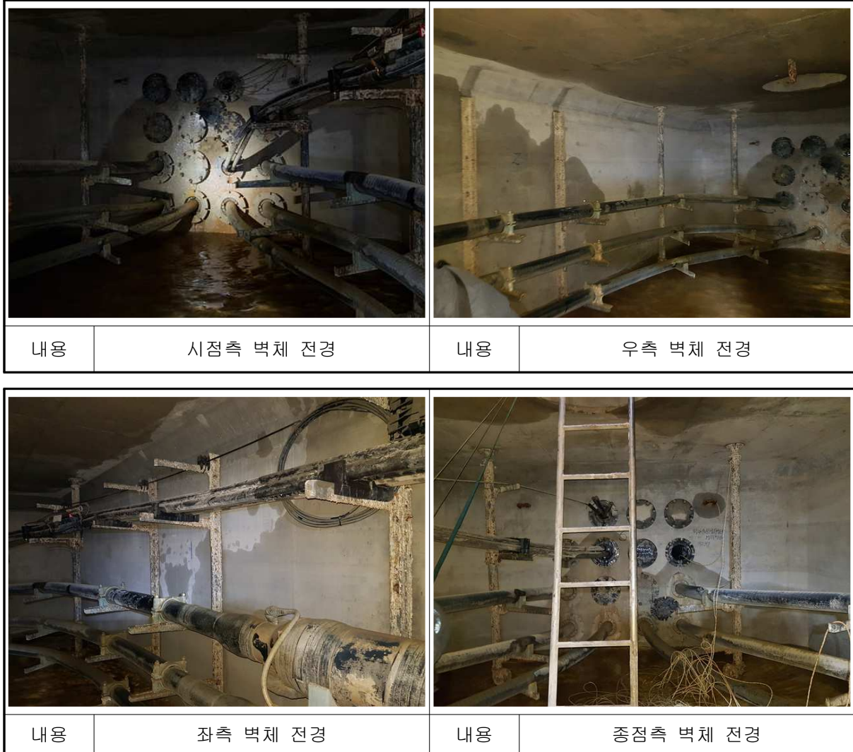
【사진 7.17】 문발~운정#3 전경
