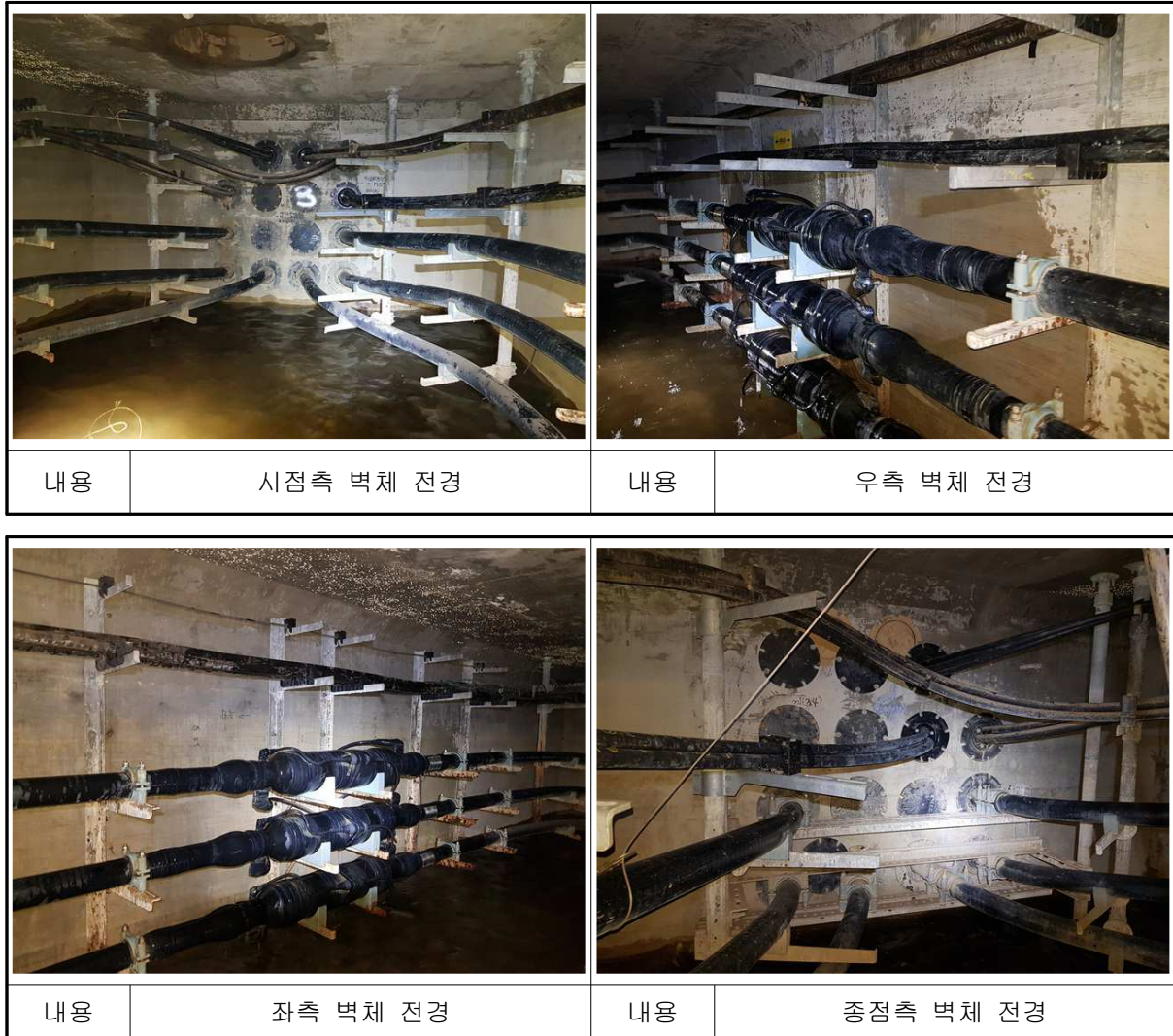
【사진 7.13】 문발~운정#4 전경
