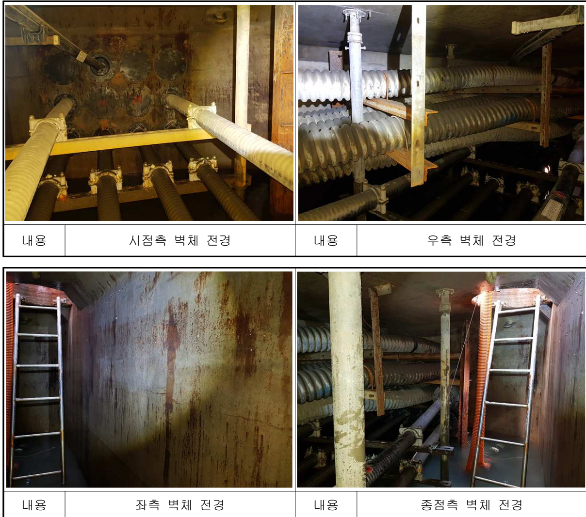
【사진 7.33】 운정~덕이 #0-1 전경
