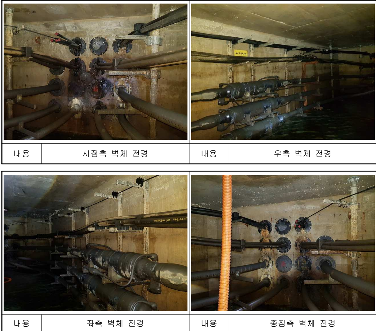
【사진 7.69】 운정~덕이#9 전경
